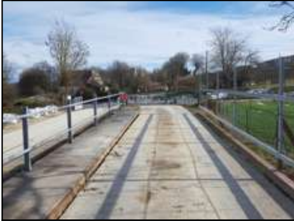
1/ Pesée du camion et premier contrôle olfactif et visuel au niveau de la bascule
